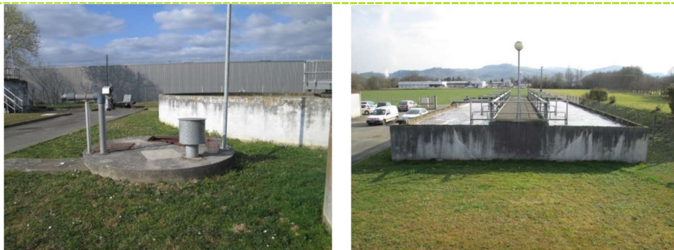
Figure 34 : Photos de la parcelle de la station de traitement actuelle (source : Hydratec, 2017)
